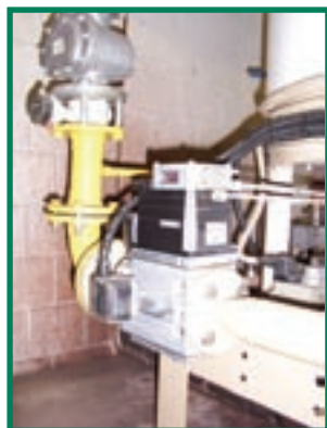
Modulerende aardgastoevoer en frequentieregelaar op de voedingswaterpomp
