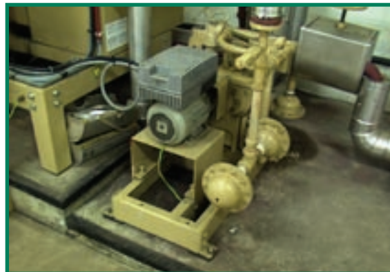
Modulerende aardgastoevoer en frequentieregelaar op de voedingswaterpomp
