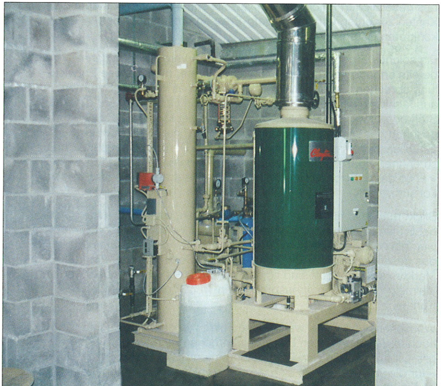
Die Dampfkessel von Clayton werden mit einer Produktionsleistung von 150 bis 20 000 kg/h geliefert.
